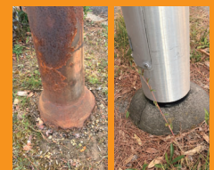
水銀灯の改修
